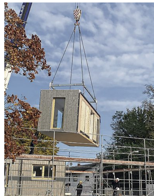
Stapelfest – die Kindergartenraummodule werden passgenau nebeneinander gesetzt und verbunden.
